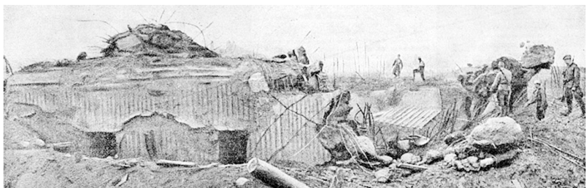
Мощный железобетонный финский дот, разрушенный советской артиллерией и авиацией в районе прорыва
